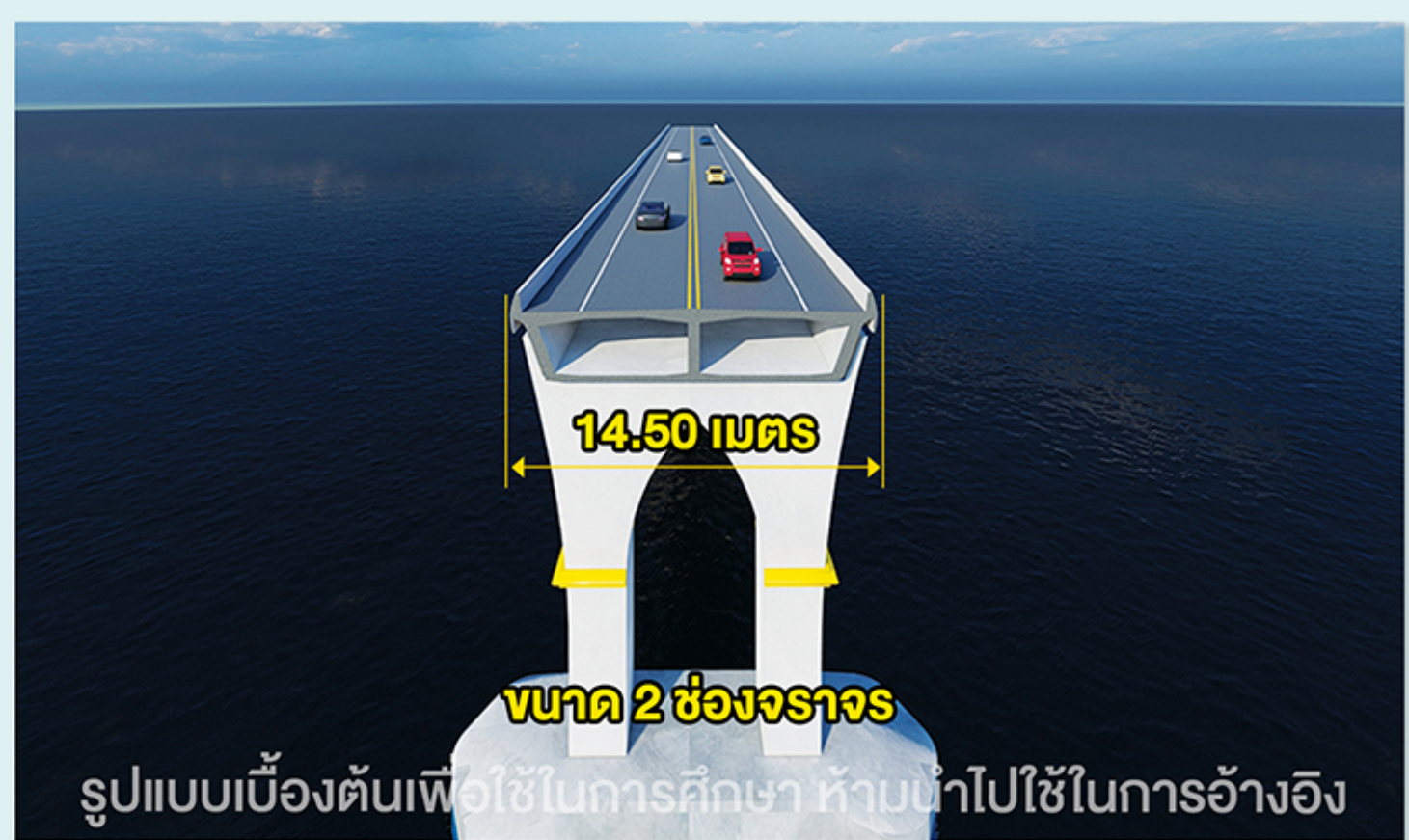
รูปตัดทั่วไปสะพานข้ามทะเลสาบสงขลา มีขนาด 2 ช่องจราจร (ไป-กลับ)
